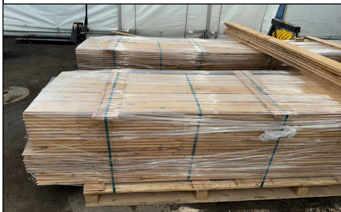
9. De rensede brædder pakkes på paller og wrap- pes i plastik.
