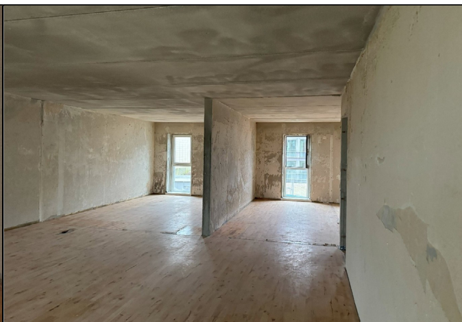
2. Skillevæggene er nedtaget og det gennemgående gulv kan tages op
